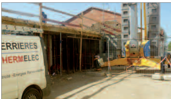
Logements sociaux : finition des travaux de gros œuvre
