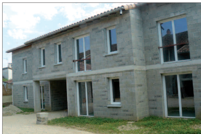
Les logements sociaux, rue du Touron, prennent forme
