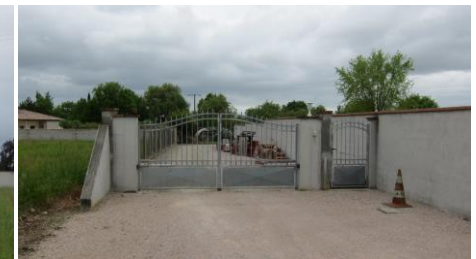
Pile 168 sur laquelle est implanté un hangar pour le stockage de matériel BTP
